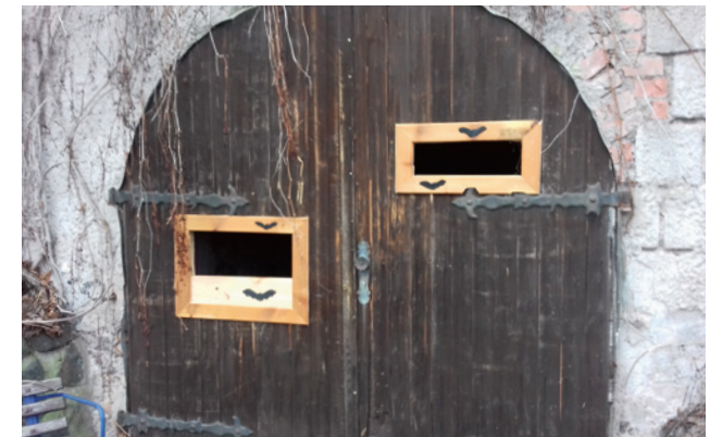
Einflugöffnungen in einer Felsenkellertür. Er kann als Winterquartier von den Fledermäusen genutzt werden. Foto: M. Biedermann
